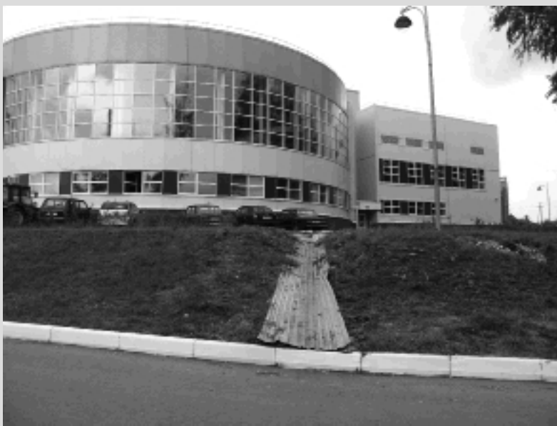
«Ливневка» у здания ФОКа
